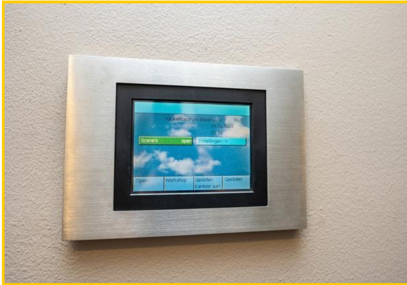
Bedieningspaneel KNX gebouwbeheersysteem.
