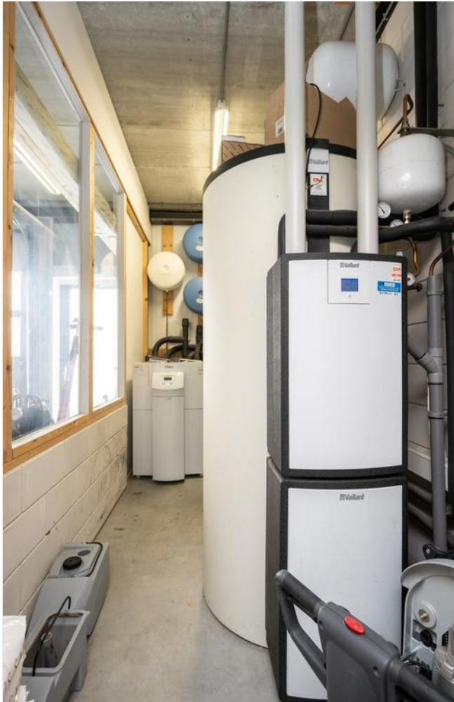
De technische ruimte met de Vaillant aardwarmte installatie, de cv-ketel, de zonneboiler en een aparte groepenkast.
