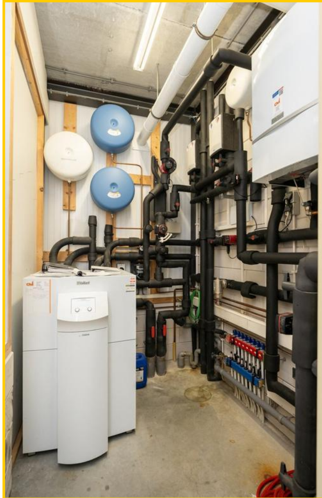
De technische ruimte met de Vaillant aardwarmte installatie, de cv-ketel, de zonneboiler en een aparte groepenkast.
