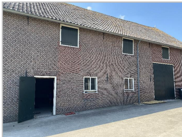
Voorgevel voorzien van openslaande deuren en loopdeur
